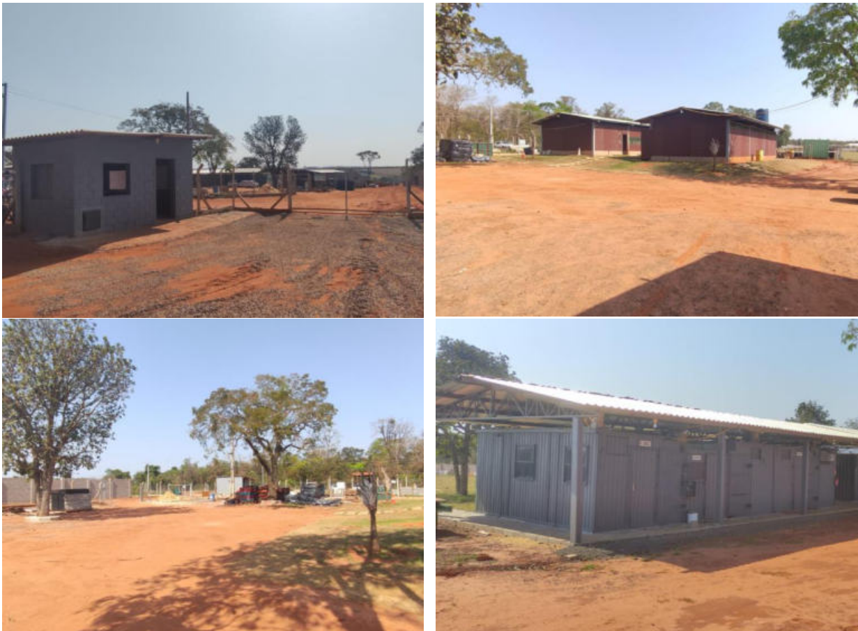
Figura 3.78 – Aspecto geral de modelos de canteiro de obras utilizado pelo empreendedor
