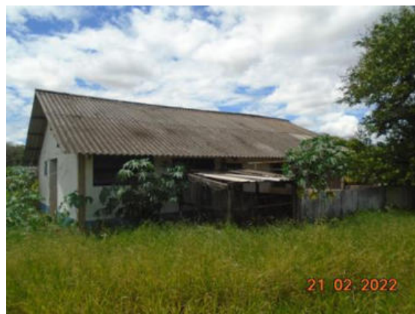
Figura 3.41 – Galpões / edificações existentes no interior do terreno
