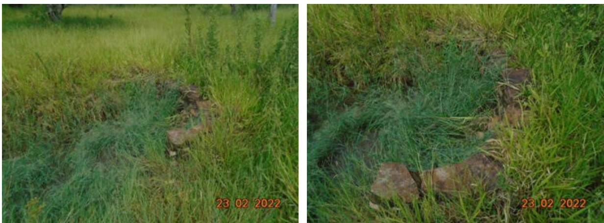
Figura 3.58 – Tubulação do canal de derivação
