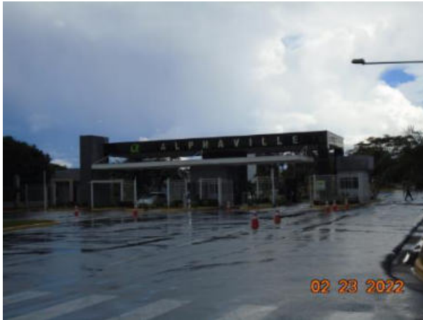
Figura 5.268 – Condomínio de Alto Padrão
