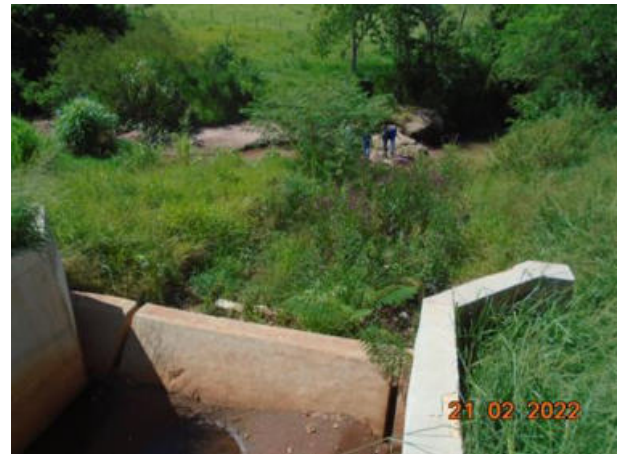
Figura 3.12 – Estrutura para lançamento de drenagem pluvial
