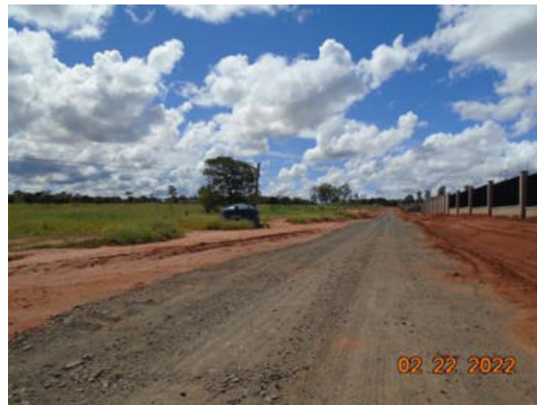
Figura 3.14 – Via de acesso ao terreno 8A
