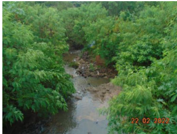
Figura 5.76 – Córrego Coqueiro sob rodovia BR-163
