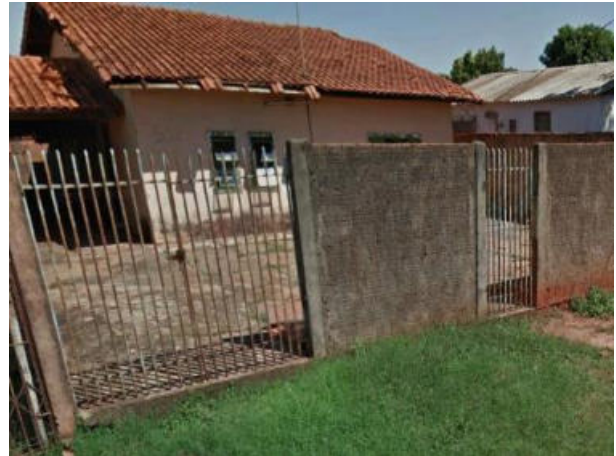
Figura 5.269 – Residências de padrão construtivo inferior
