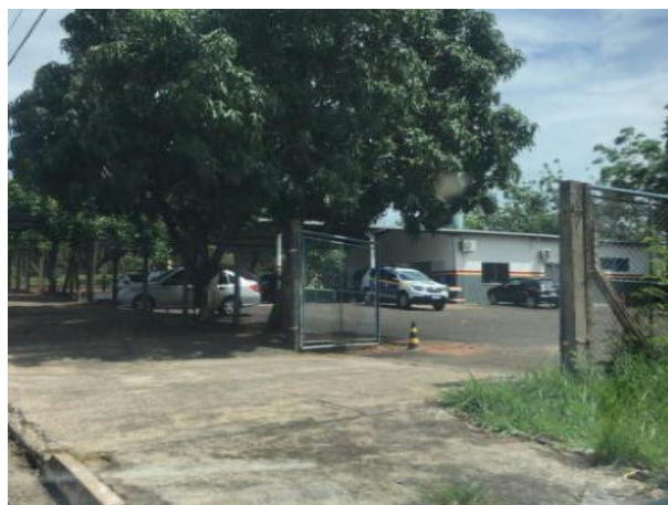
Figura 5.248 – Guarda Civil Metropolitana
