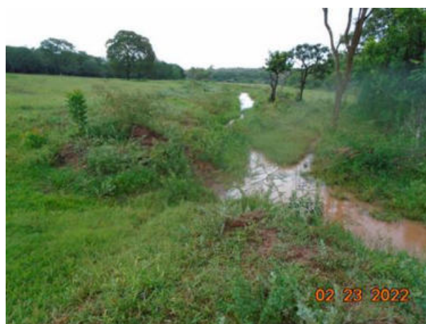
Figura 3.62 – Canal de derivação nos terrenos 21, 22 e 23, respectivamente
