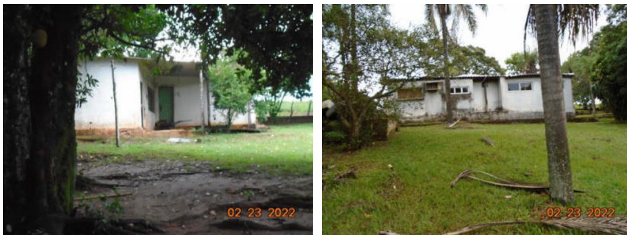
Figura 3.66 – Edificações verificadas no terreno
