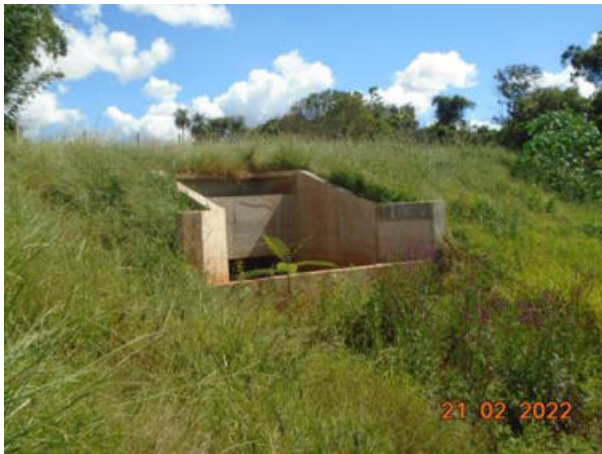
Figura 3.12 – Estrutura para lançamento de drenagem pluvial
