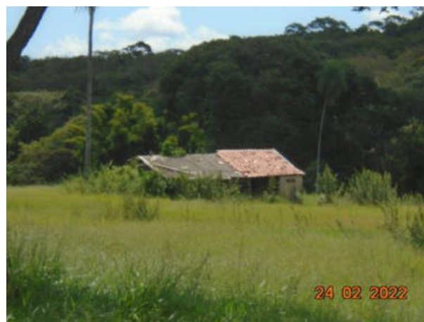
Figura 3.55 – Edificação desocupada no terreno 18
