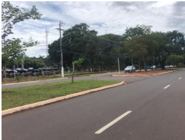
Figura 5.283 – Vias pavimentada região oeste
