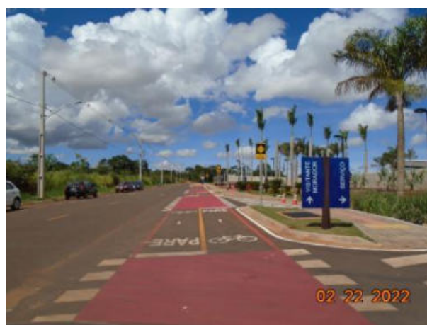
Figura 5.267 – Sinalização e ciclovia junto a via pavimentada
