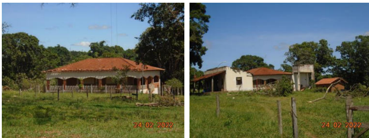
Figura 3.19 – Vista da residência em bom estado de conservação
