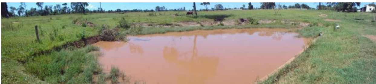
Figura 5.88 – Vista geral do reservatório R-07
