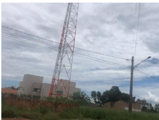
Figura 5.297 – Antena de telefonia e iluminação pública
