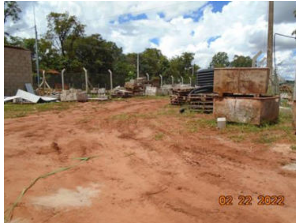
Figura 3.28 – Canteiro de obras do empreendimento licenciado
