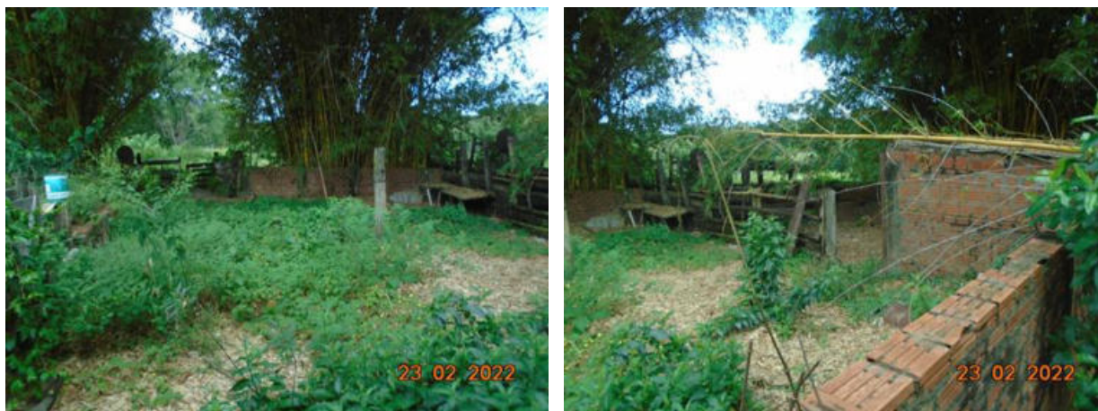
Figura 3.60 – Edificação desocupada do terreno 20
