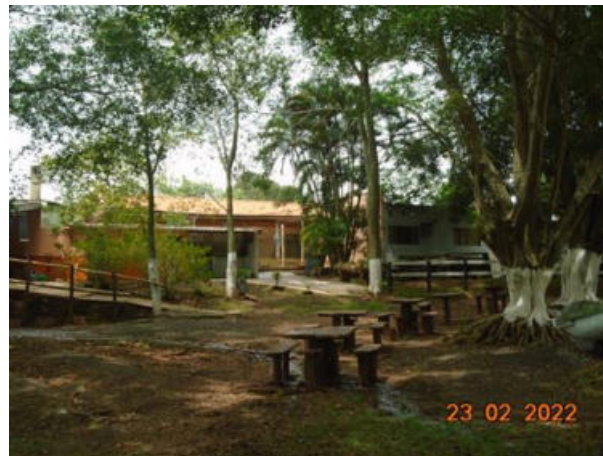
Figura 3.54 – Aspecto geral das edificações no terreno 18
