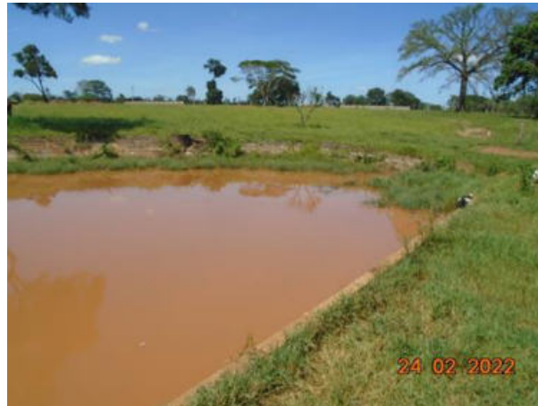
Figura 3.25 – Reservatório com paredes em alvenaria
