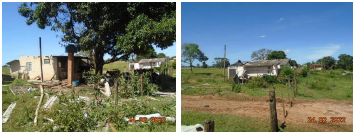
Figura 3.23 – Ruínas de edificações
