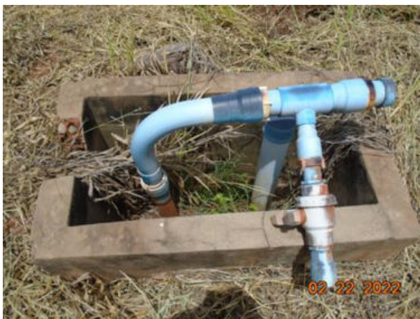
Figura 3.44 – Tubulação de distribuição de água
