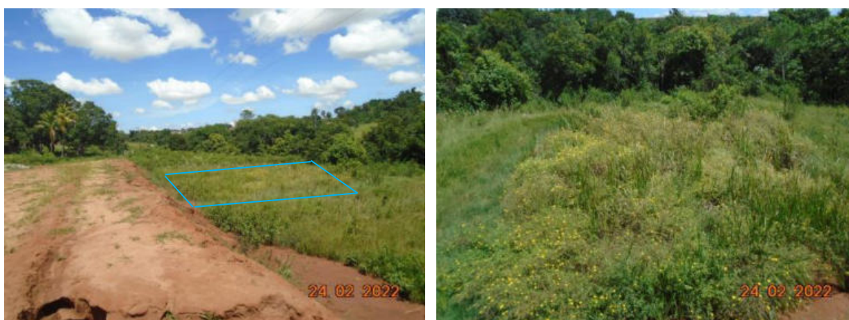
Figura 5.89 – Vista geral do reservatório R-08, desativado e recoberto por vegetação
