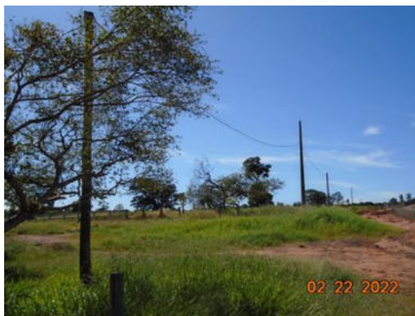
Figura 3.18 – Poste de energia e cerca ao fundo
